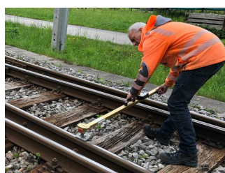
Mesure d'une inspection d'aiguillage
