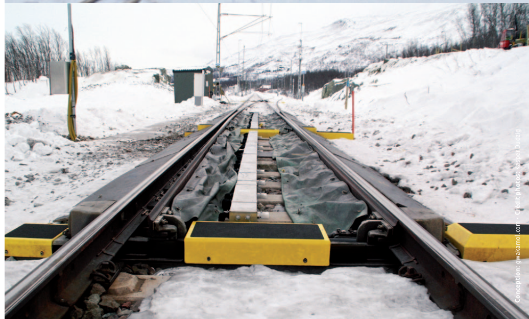
Voie à charges lourdes, Suède
